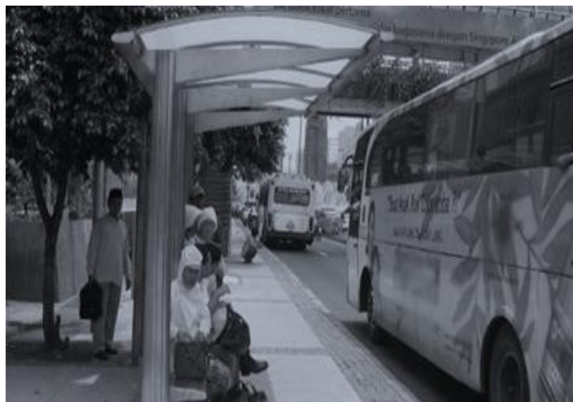
Gambar 2.15 Contoh struktur balok kantilever pada kanopi
