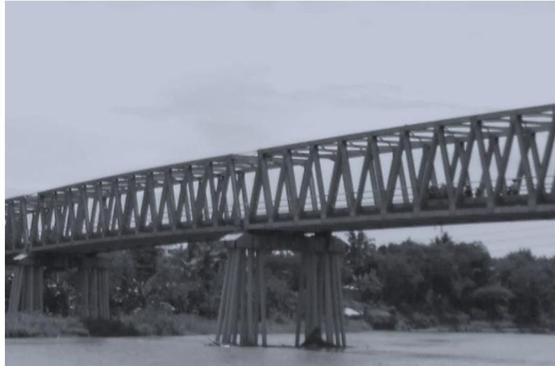
Gambar 2.16 Jembatan Kretak Yogyakarta struktur rangka ( Truss ) 3 dimensi
