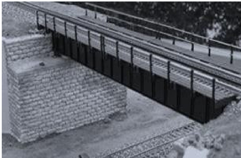
Gambar 2.14 Contoh struktur balok sederhana pada jembatan
