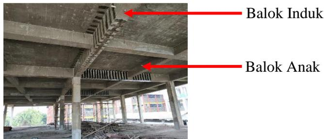
Gambar 3.7 Struktur Balok
