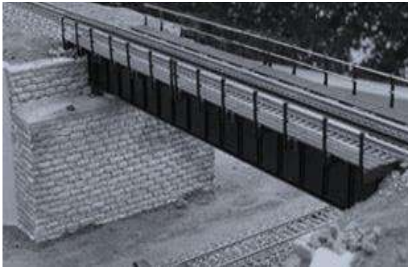
Gambar 1.14 Contoh struktur balok sederhana pada jembatan
