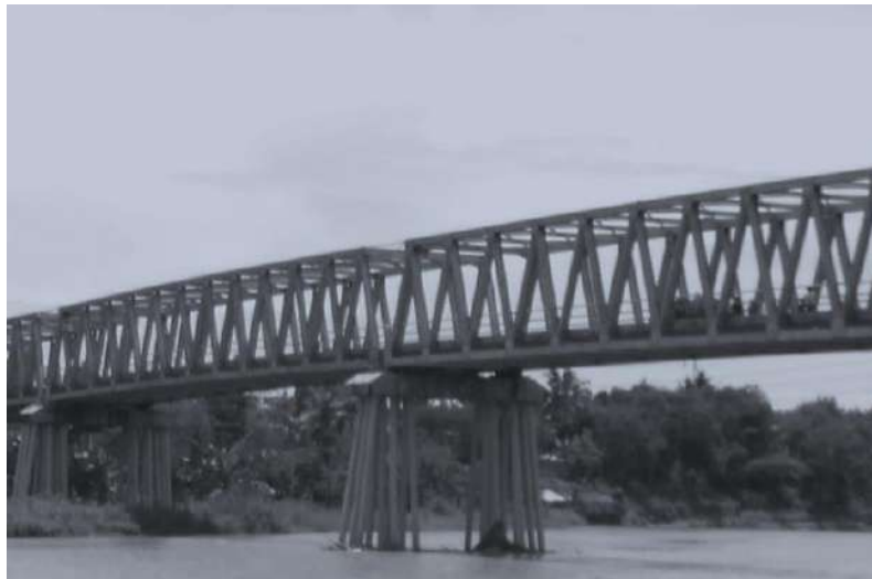
Gambar 1.16 Jembatan Kretan Yogyakarta struktur rangka ( Truss ) 3 dimensi
