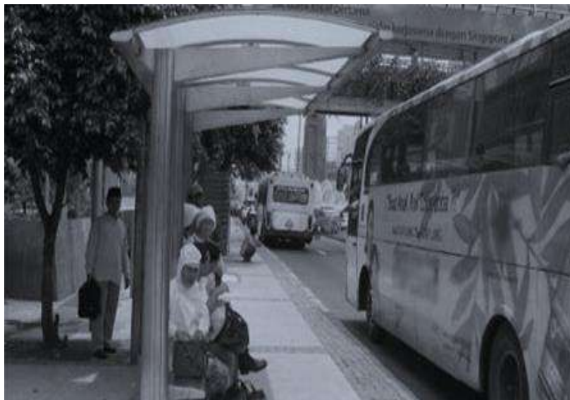
Gambar 1.15 Contoh struktur balok kantilever pada kanopi
